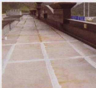
重髹冷氣機房頂鋅鐵皮
