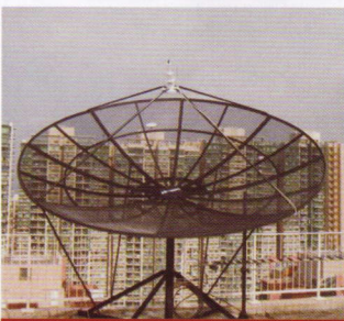
更換衛星天線設備
