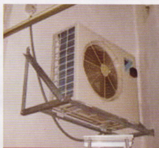
更換保安部冷氣機
